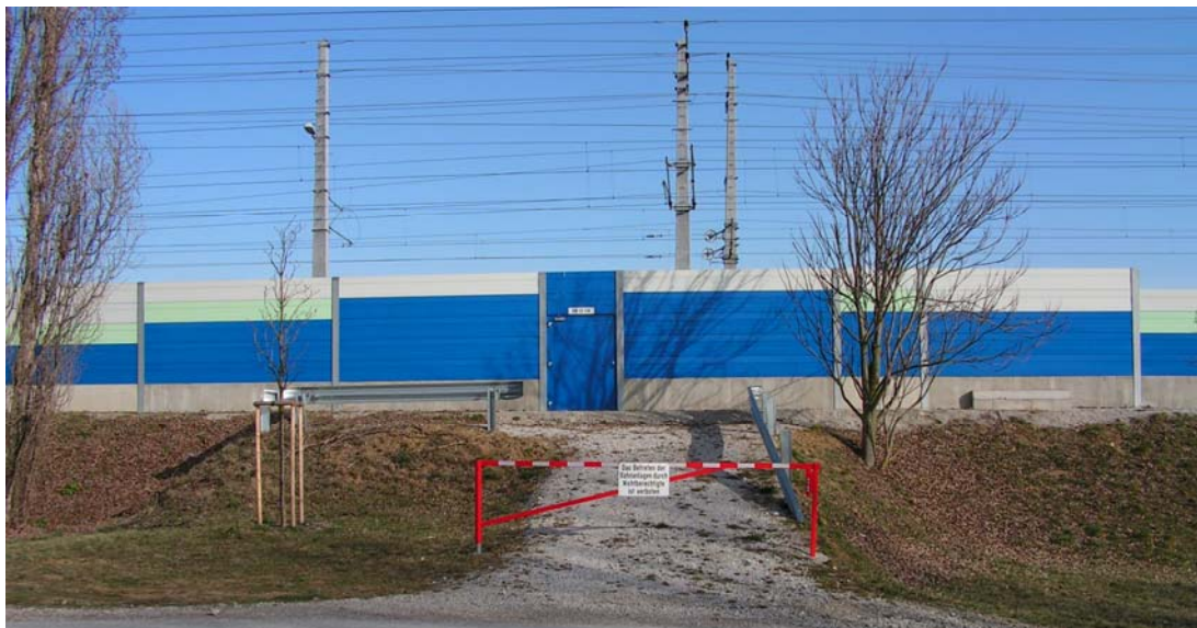
Abbildung 11.01 – Lärmschutzwand
