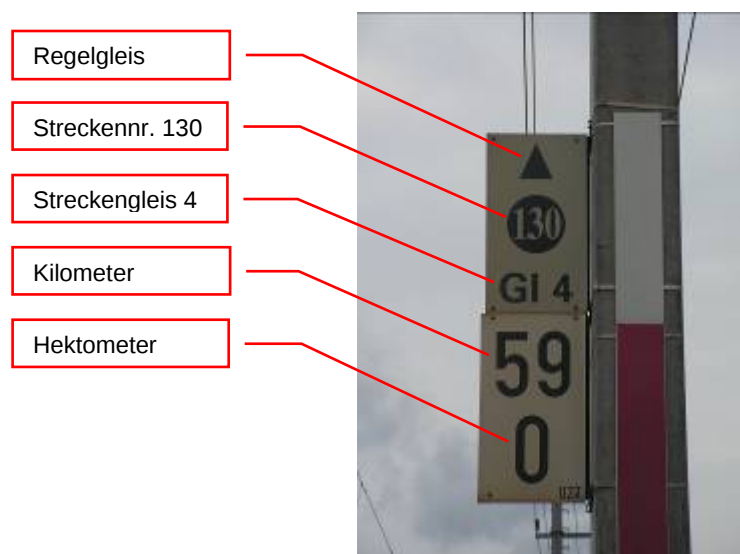
Abbildung 6.02 – Hektometertafel auf nebeneinander verlaufenden Strecken
